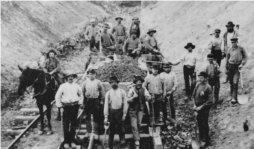
Norra Södermanlands Järnväg, bygget 1893 Källa: Informationstavla i Åkers styckebruk
